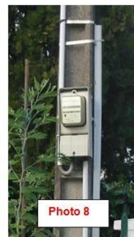
Compteur extérieur apparent
