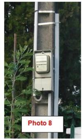
Compteur extérieur apparent
